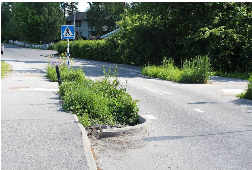
Figur 26. Exempel på regnbäddar, Malmö. Stenpartiet vid inlopp är ett erosionsskydd. Källa: Ramboll.
